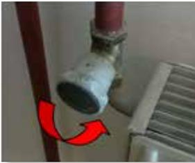
1. Ventil "rückdichten". Das Ventil muss durch Linksdrehung bis zum Anschlag vollständig geöffnet werden. Handrad abnehmen.
